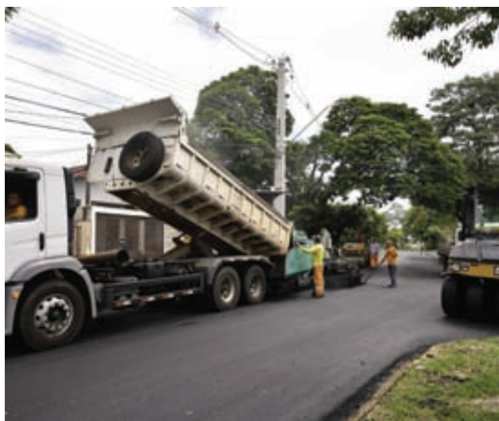
A Prefeitura de Umuarama concluiu mais um trecho de recapeamento asfáltico em importantes avenidas cidade
